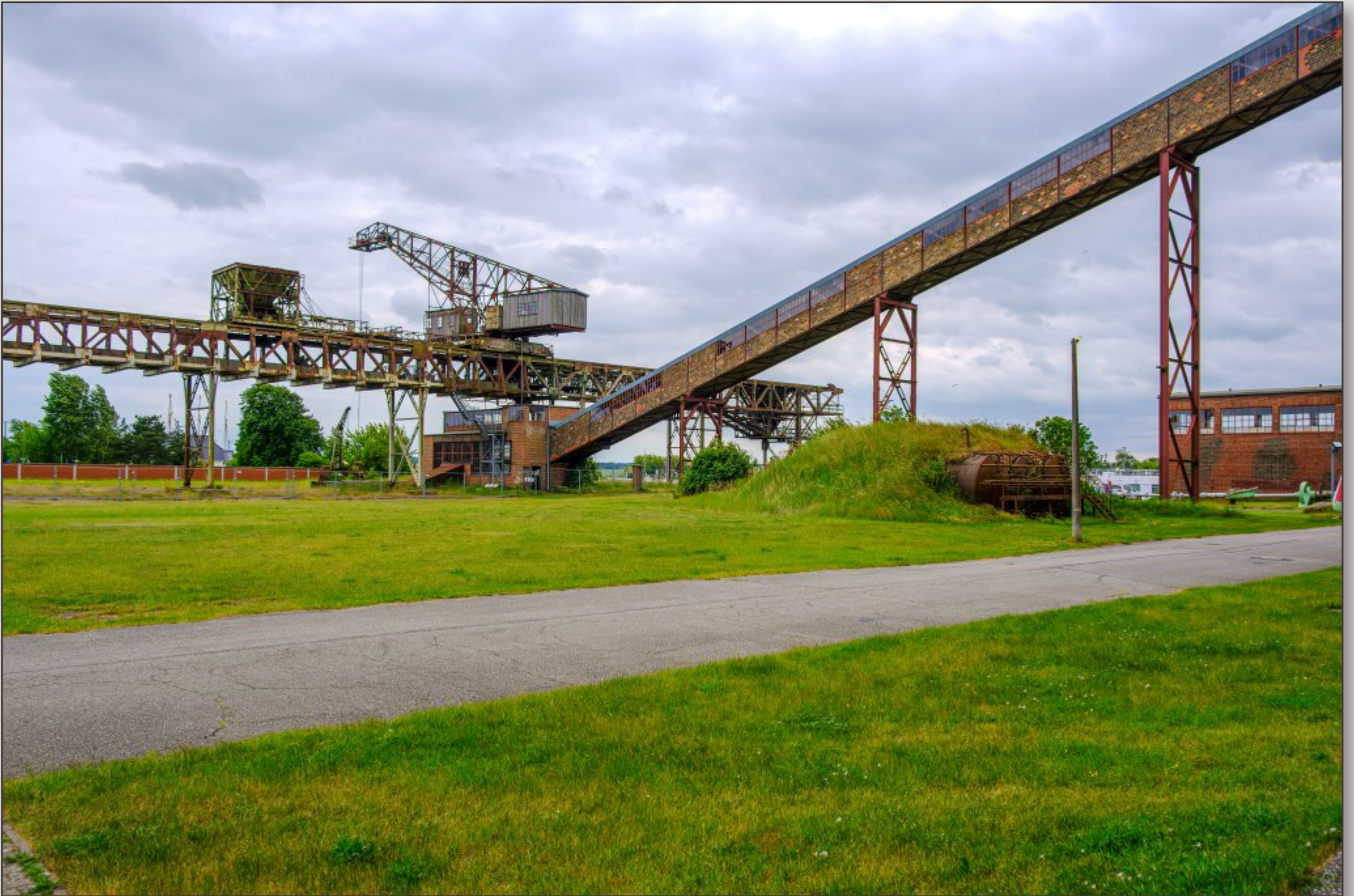
Kraftwerk Kranbahn, Brechhaus und Kohleförderband
